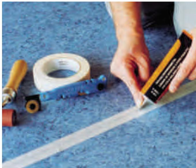
Одна из проблем, с которыми можно столкнуться при укладке линолеума, — образование швов между полотнами. Со временем в таких швах скапливается грязь, вода и бактерии, края шва загибаются, покрытие отстает от основания. Шов выглядит некрасиво, место шва быстрее изнашивается... и вот ваше напольное покрытие уже нуждается в замене или ремонте.
